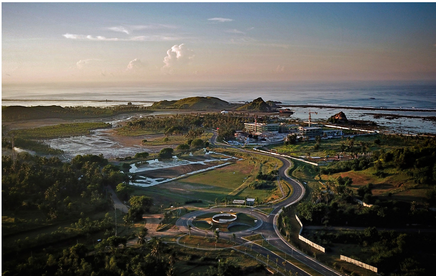
Photographie aérienne de Mandalika montrant la construction du circuit moto et des infrastructures touristiques de Mandalika. (Photo par Arsyad Ali / AFP)
