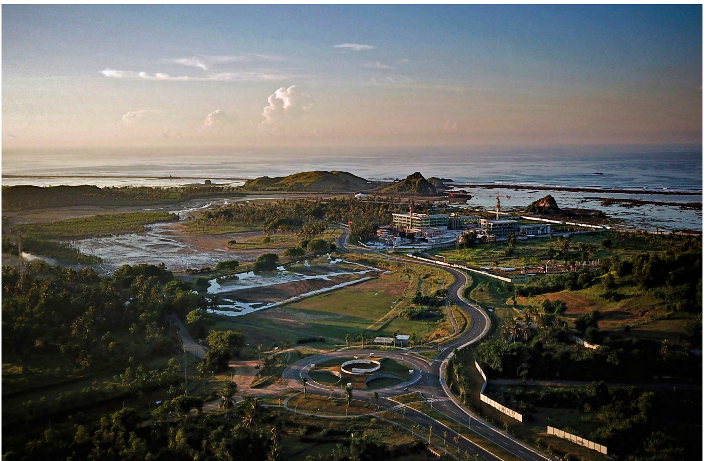
Luftaufnahme von Mandalika, die den Bau der Mandalika-Motorradrennstrecke und der touristischen Infrastruktur zeigt. (Foto von Arsyad Ali / AFP)
